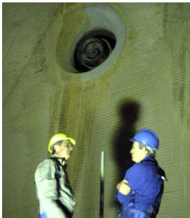
Figura 1 – Queimador do evaporador e posicionamento dos tubos da parede d'água
