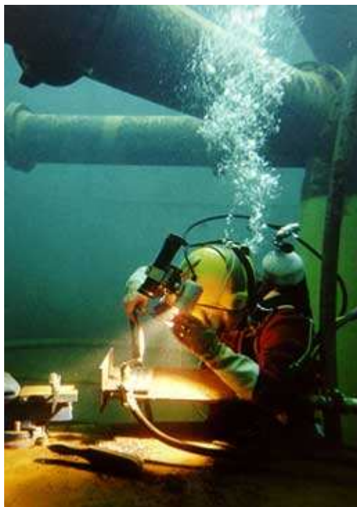
Figura 3.7 – Soldagem com arame tubular no tanque do TWI, Inglaterra [32].
