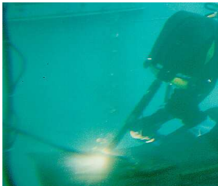
Figura 7.8 - Soldagem manual na posição plana.
