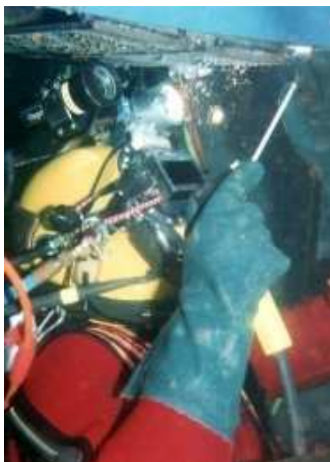
Figura 3.1 – Soldagem molhada com eletrodo revestido [13].
