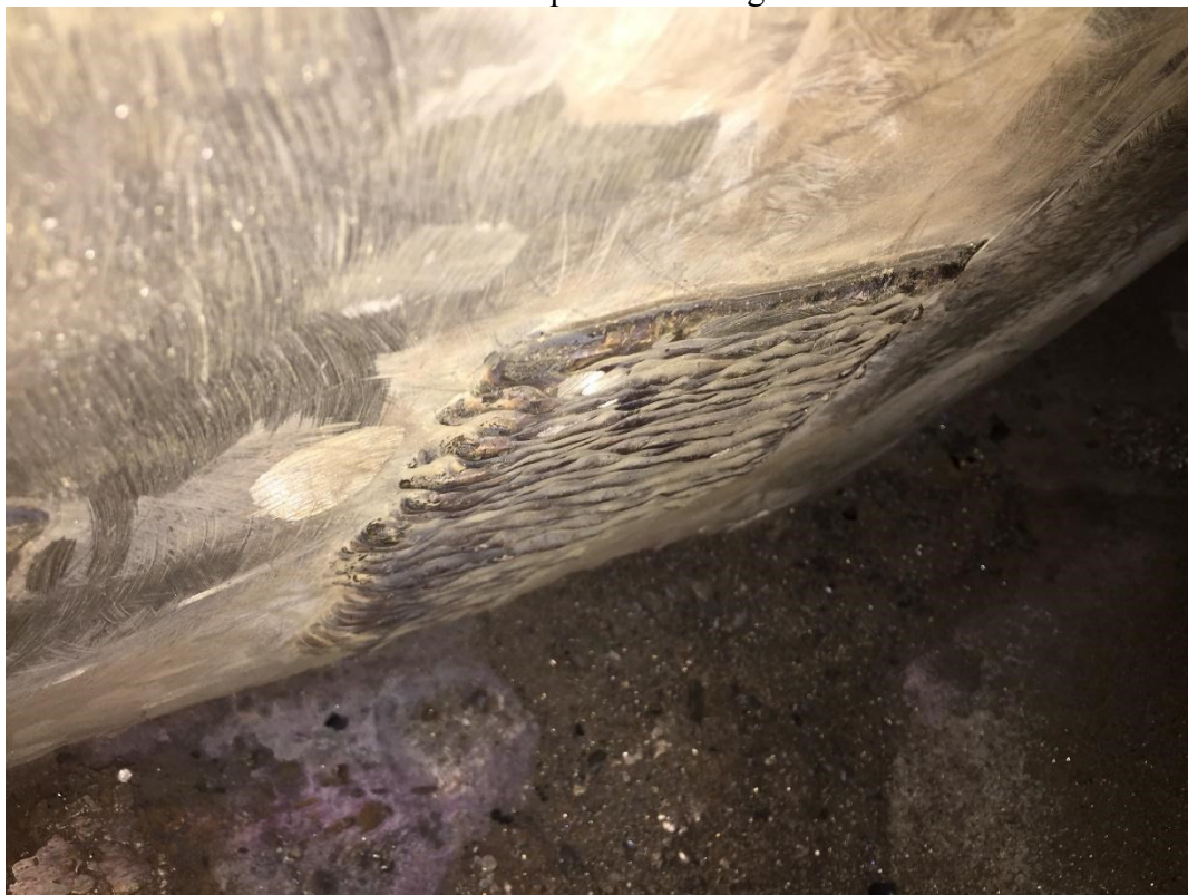
Figura 1 - Imagem mostrando a sequência de cordões de solda realizados em progressão horizontal para depositar uma camada de aço inox 309 na superfície da pá de turbina hidrelétrica que sofreu desgaste.
