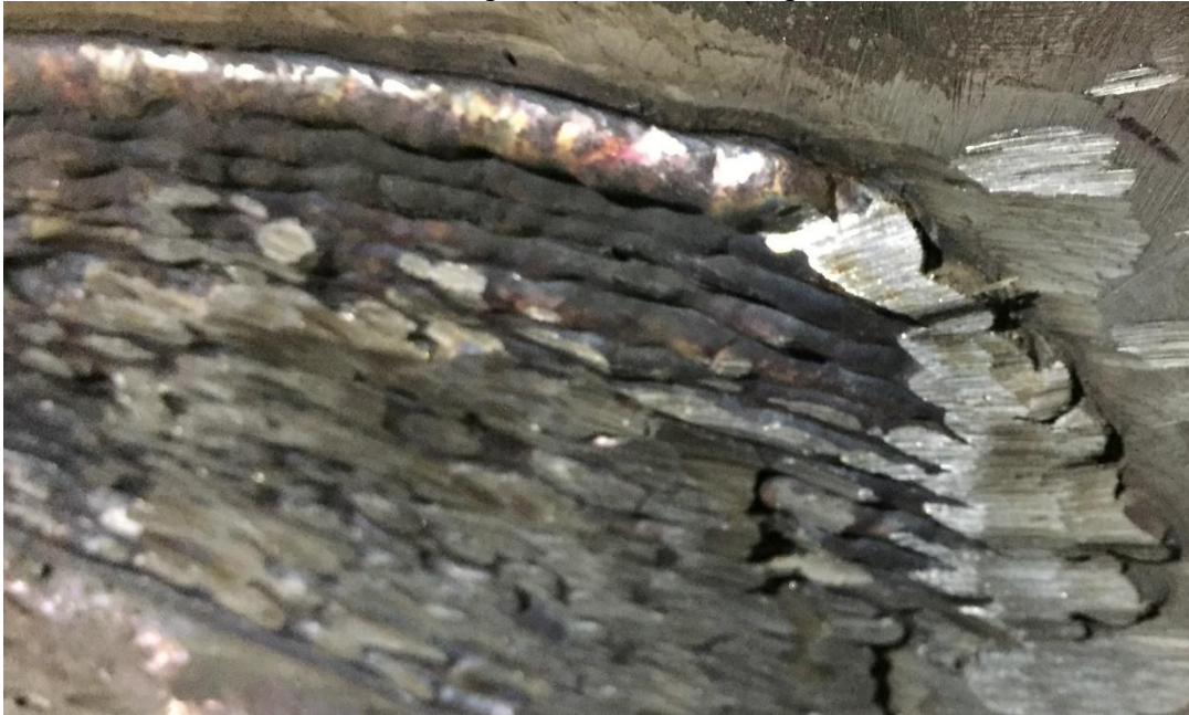
Figura 2 - Região onde foram depositados cordões de solda realizados em progressão horizontal para depositar uma camada de aço inox 309 na superfície da pá de turbina hidrelétrica que estava sendo recuperada.
